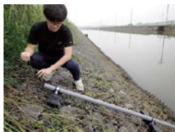
低地排水路への水位計の設置
