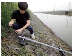
低地排水路への水位計の設置
